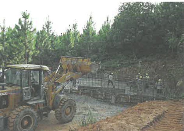
/ 韶关市乡村振兴公益基金会项目——安全饮用水提升工程施工现场
